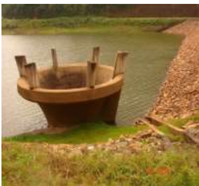
Photo 2: Niveau du barrage de la CHE de Rwegura en 2007
