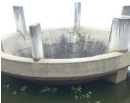
Photo 1: Niveau du barrage de la CHE de Rwegura en 2004
