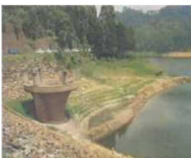
Photo 3: Niveau du barrage de la CHE de Rwegura en 2008
