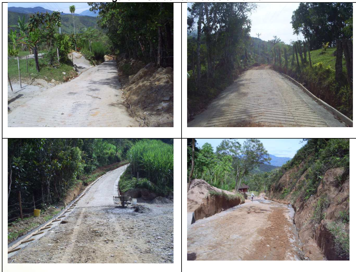
Figura 7. Obras realizadas en la vía
